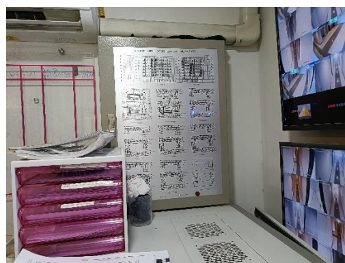
แผงควบคุมระบบแจ้งเหตุเพลิงไหม้ (Fire Alarm Control Panel ; FCP)
