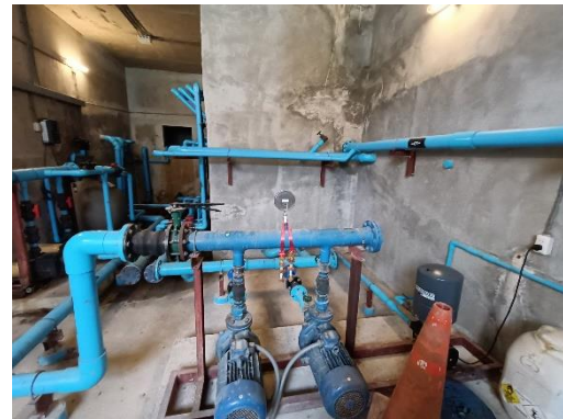
ปั๊มสูบน้ำใช้ขึ้นไป ถังเก็บน้ำชั้นหลังคา
